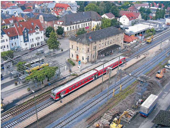
Das Areal um den Öhringer Hauptbahnhof soll in einem städtebaulichen Wettbewerb zum „Mobility Hub“ umgestaltet werden
